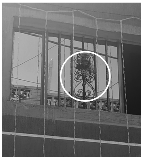
FIGURA 19. Instalación de sensor de fondo 2
