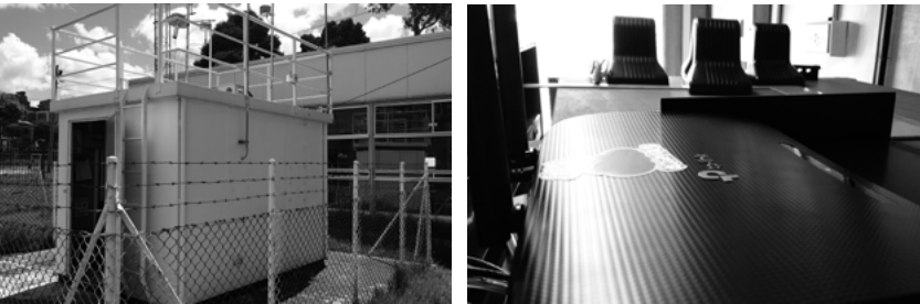
FIGURA 12. Instalación de la estación de calidad del aire oficial Tunal
